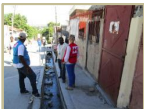
Photo CFF_1: Wastewater drain on Rue D'Eau
